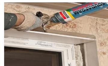
слой пены в узел соединения панели с окном. (Это не только улучшит теплоизоляцию шва, но и панель лучше прижмется к раме окна).
